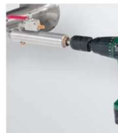
Wiercenie pod ciśnieniem z użyciem przyrządu wiertarskiego CS
